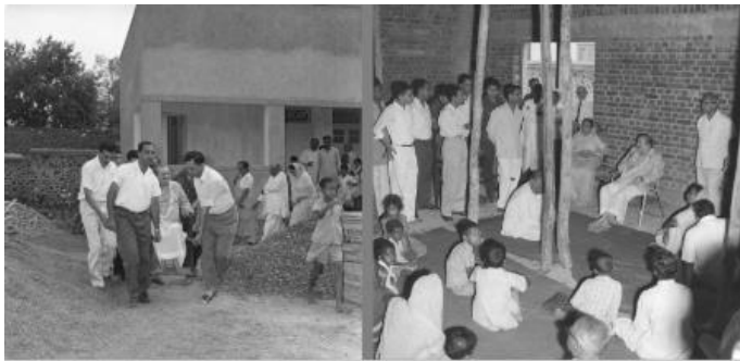
பூனா மையத்தின் கட்டுமான பணி, ஜூன் 1963 – தூக்கு நாற்காலியில் பாபாவிற்கு உதவியாக தாரா தாதாசாஞ்சி, ஜெஹாங்கு ஸுகத்வாலா, ஆதி துபாஷ் (POONA CENTER UNDER CONSTRUCTION, JUNE 1963 – DARA DADACHANJI, JEHANGU SUKHADWALA, ADI DUBASH CARRYING THE LIFT CHAIR)
